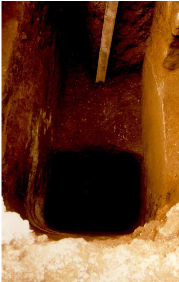
Figura 7.- Vista cenital de la cisterna excavada, con las esquinas redondeadas (Mata, 1997).
