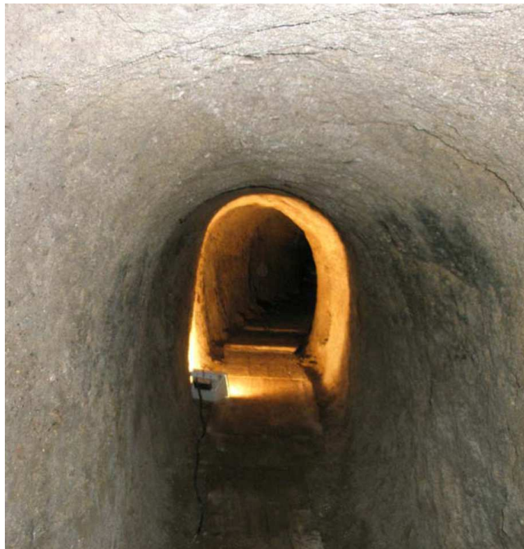
Figura 9.- Vista general de la galería que transcurre hacia la Catedral (hacia el Oeste). Se puede observar la bóveda tallada directamente en el nivel geológico (Jurado, 2012: 38).
