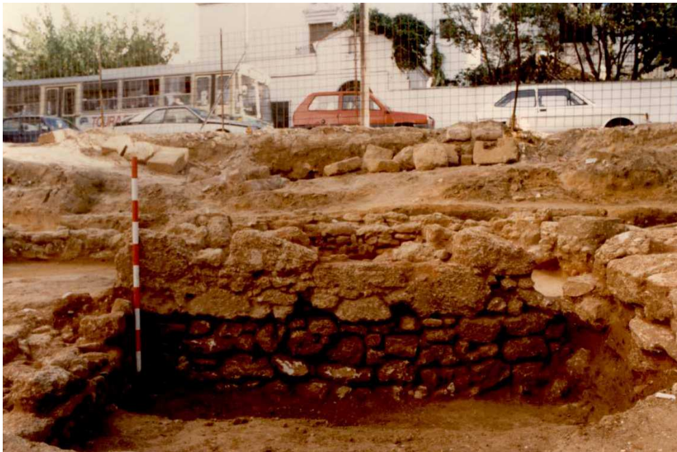
Figura 5.- Detalle de la técnica constructiva de uno de los alzados conservados de una de las estancias del edificio (Sáenz, 1990: lámina 1).
