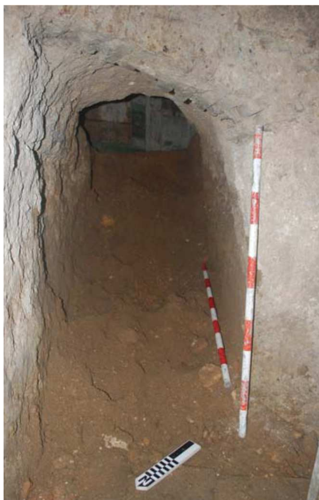
Figura 7.- Vista general durante el proceso de excavación de la galería desde su extremo NO (tramo que discurre hacia el teatro romano) (Jurado, 2012: 36).
