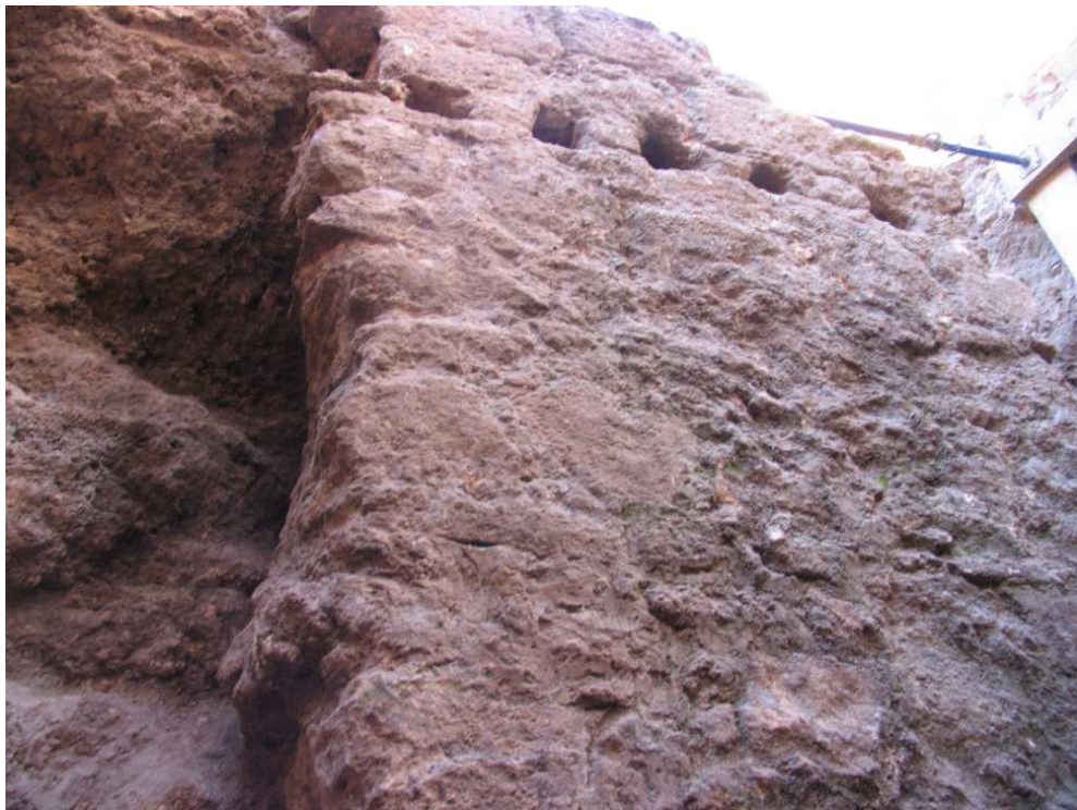
Figura 9.- Mechinales de la estancia oriental, que indican el nivel de uso de la segunda planta (cortesía de M.E. García Pantoja).
