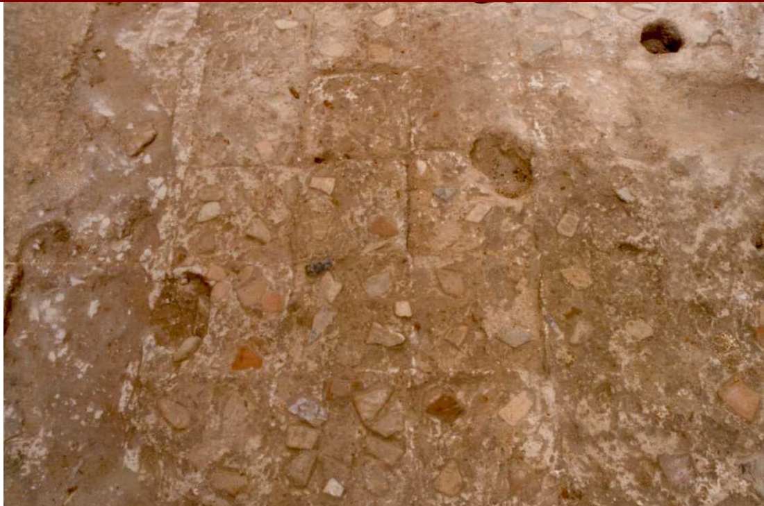
Figura 6.- Detalle del pavimento con la base para la colocación de las placas que se localizaban en la zona central del patio (Sáenz, 1990: lámina 8).
